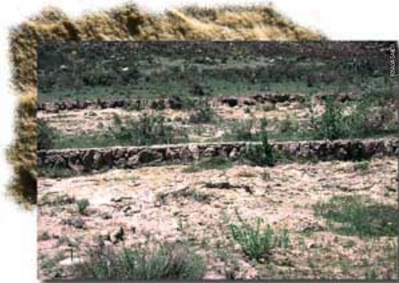
La construcción de terrazas en terrenos con pendientes perceptibles frena la erosión del suelo y permite el mejor manejo de los sedimentos y de la humedad del sustrato disponible para la vegetación.
